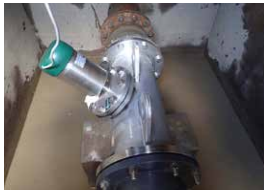
施設の更新・修繕
