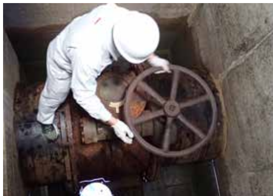
施設の点検作業
