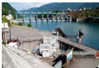
改修後の池田取水工(池田町)
