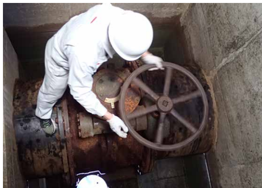
施設の点検作業
