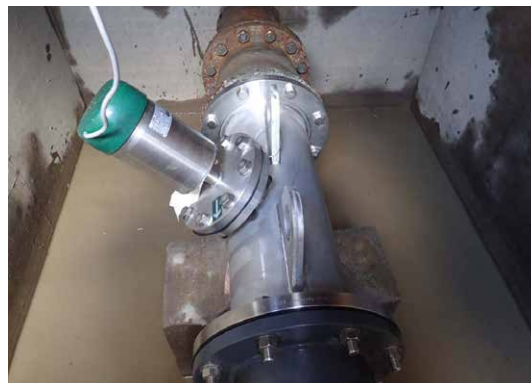
施設の更新・修繕
