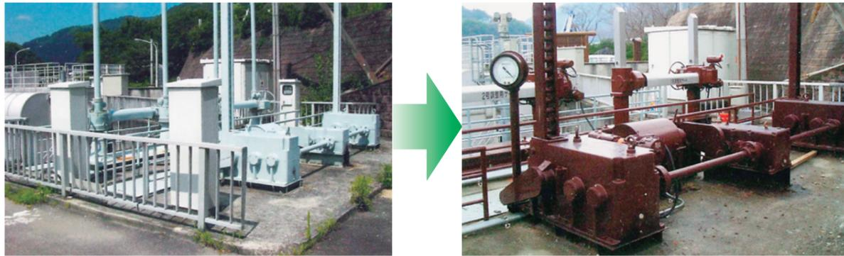
小川谷頭首工 クラック補修、スクリーン整備、護床敷設替、魚道取付、ゲート塗装塗替、開閉装置更新
