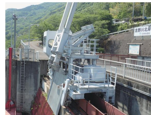
写真5-1 移動式除塵機
