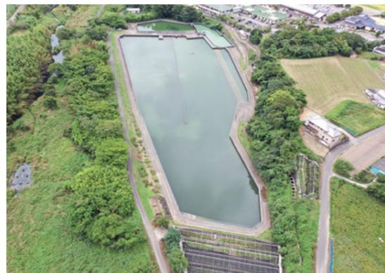
宮川内調整池（調整容量 $V=35,000\text{m}^3$ ）
