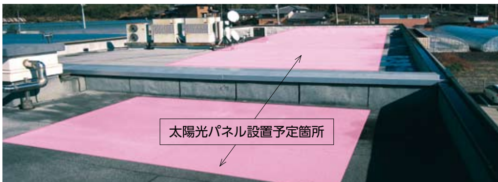
吉野川北岸土地改良区中央管理所屋上
