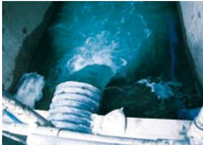
仮設による送水（毎秒1トン）
