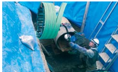
管水路の補修工事(阿波市阿波町)
