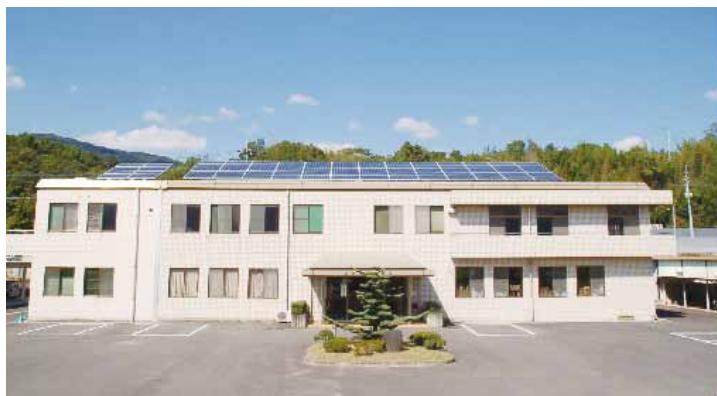
吉野川北岸土地改良区中央管理所
