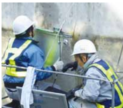
レーザー測定器を使った摩耗量調査
