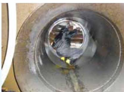
水量調節のため開閉するバタフライ弁を点検
