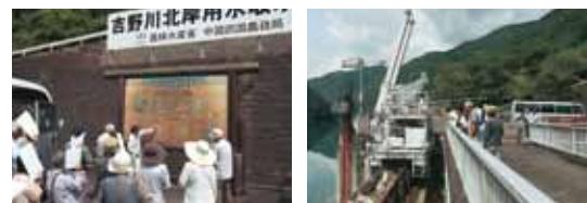
北岸用水池田取水工(三好市池田町)
