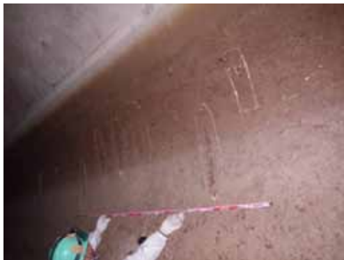
水路内の鉄筋露出状況
