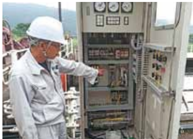
通信状況の確認
