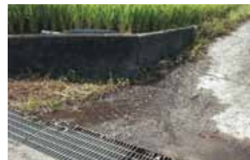
畦のひび割れなどから絶えず水が流れている
