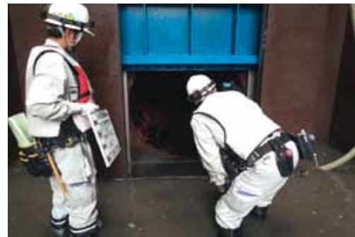
宮川内調整池(阿波市土成町)施設調査
