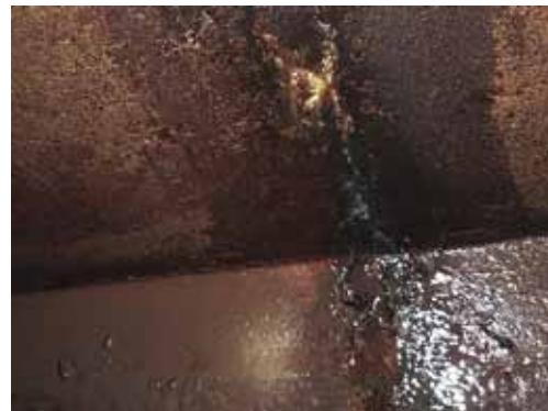
水路内への漏水状況
