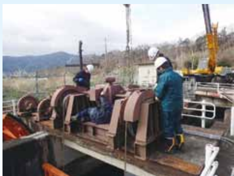
水位調整ゲートの補修工事の様子
