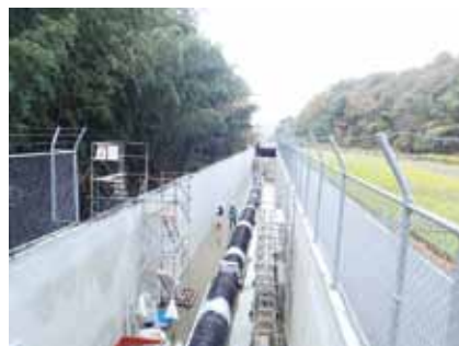
幹線水路内の工事の様子。工事区間に設置した仮設水路で通水をしなが、工事が行われました。(三好市池田町)
